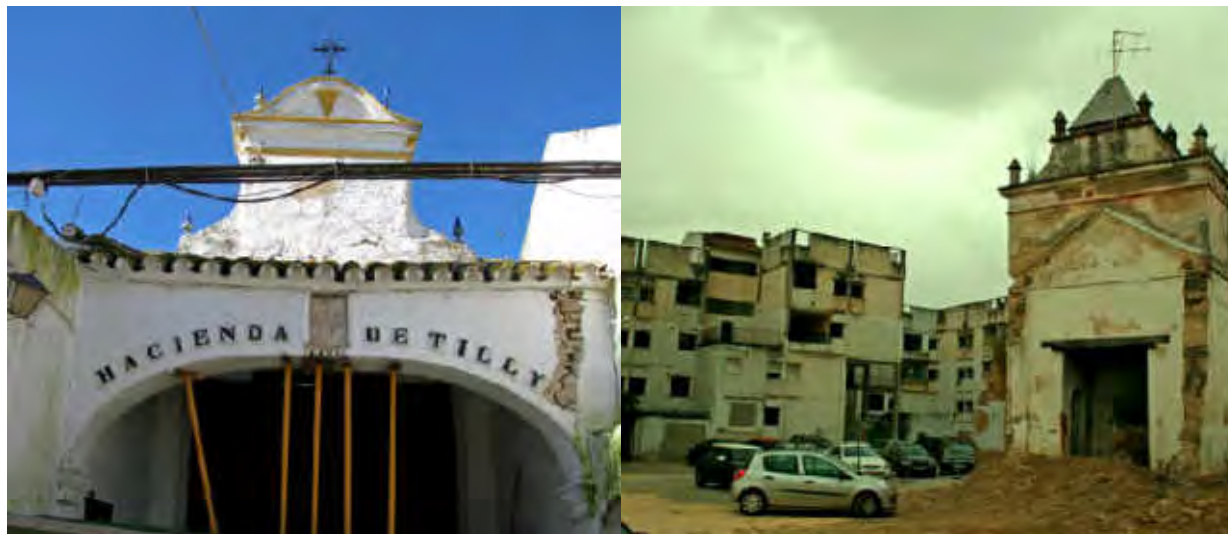
Figuras 26 y 27. El estado de deterioro y abandono es aún patente en muchas haciendas, como la Hacienda de Tilly, en Valencina de la Concepción (izquierda), carente de uso y en venta. En otros casos, la situación ha sido irreversible, como en la desaparecida Hacienda Casa Grande, en Mairena del Aljarafe (derecha), cuyo solar ha servido como aparcamiento improvisado. La torre de contrapeso ha sido testigo de su desolación. (Fotos: 30/01/2010 y 17/05/2013 respectivamente).
