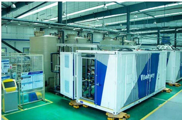
Figura 24. Modelo de batería de flujo redox de vanadio Rongke Power. [57]
