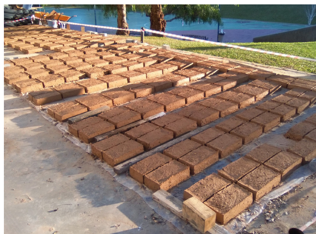
Figura 1. Secado al aire de las unidades de adobe.
