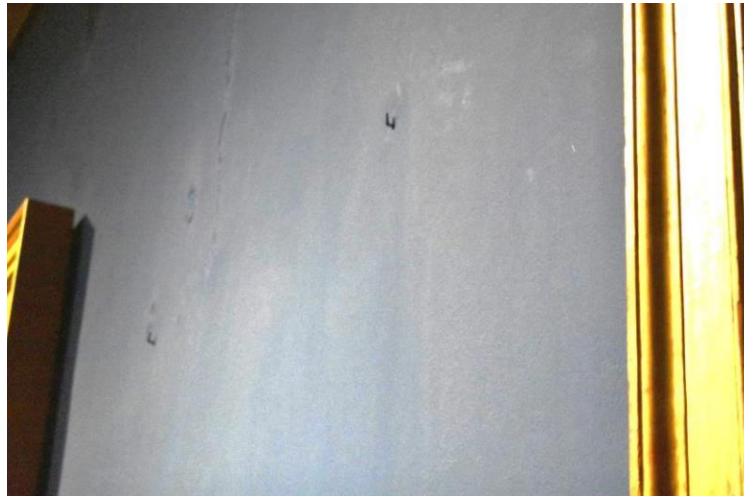
Fig.27. Anclaje superior en las obras de la Pinacoteca.
