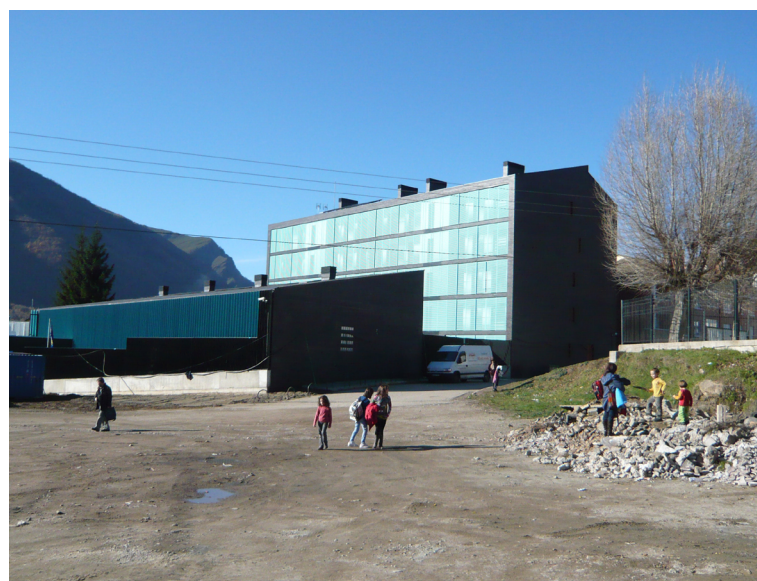
Figura 9. Imagen exterior de la casa cuartel de la Guardia Civil de Villablino (León). Autores: Francisco Javier Sáenz Guerra y Soledad Rodríguez Lozano, 2011.
