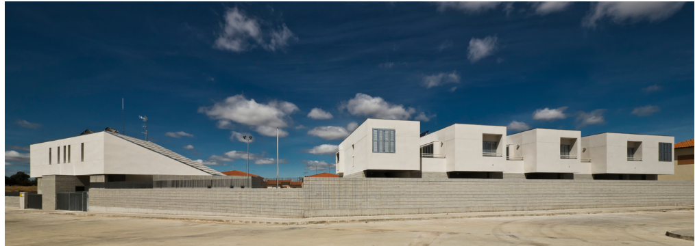
Figura 10. Fachada exterior del conjunto de la casa cuartel de Malpartida de Plasencia (Cáceres). Autor: Juan Carlos Quindós de la Fuente, 2011.
