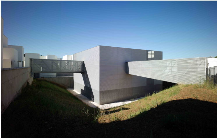
Figura 6. Imagen exterior de la casa cuartel de la Guardia Civil de Aracena (Huelva). Autor: Emilio Fernández, 2011.
