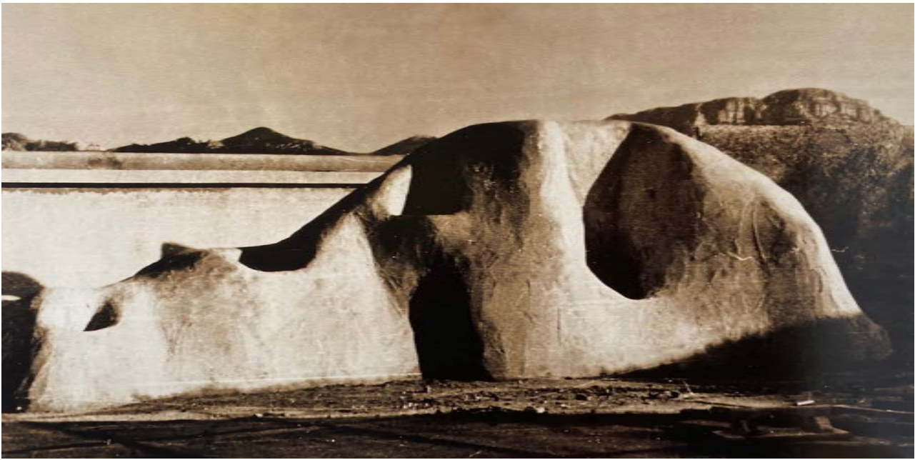
Fig. 01. Montículo artificial en la cubierta de la Unité d'Habitation Marsella. AV Monografías 176 (2015), página 52.
