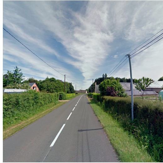
Figura 6. Fachadas a carretera, 20 La Petite Garenne, Jupilles (Francia). Crédito de la fotografía: © 2022 Google. Fuente: Google Maps, Street View. https://goo.gl/maps/D78u-hfGyDSLmwYqda
