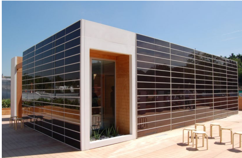
Fig. 2 Paneles solares integrados en la fachada
