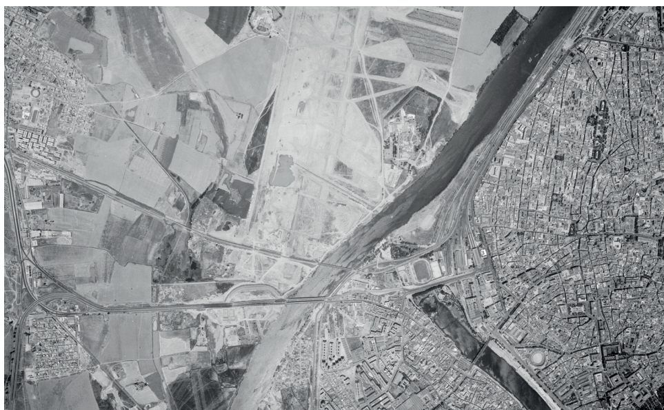
FIG. 3/ Inicio de las obras de la corta de la Cartuja (1977)
