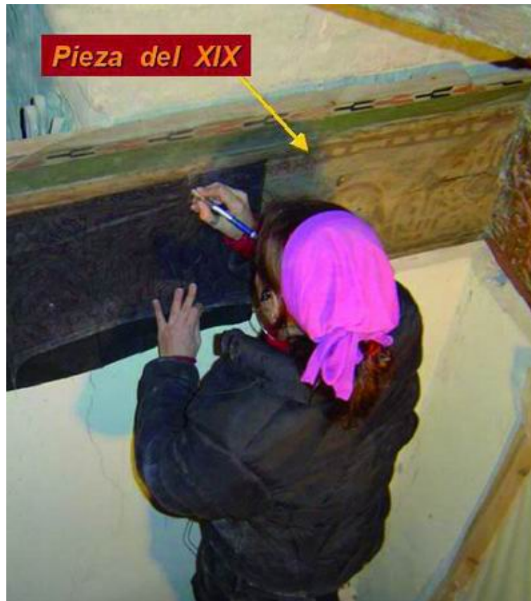
Fotos 70-71. Reposición de distintos elementos estructurales.
