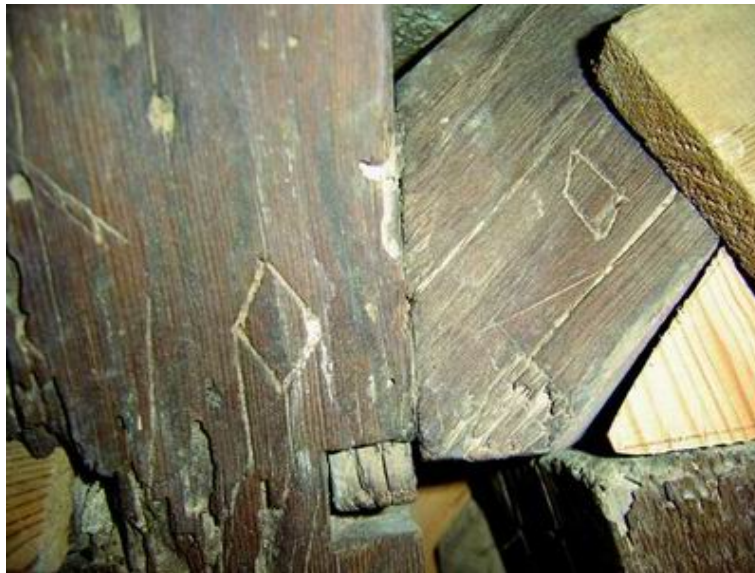
Foto 20. Marcas en las alfardas y peinaos como referencia para su montaje o traslado.
