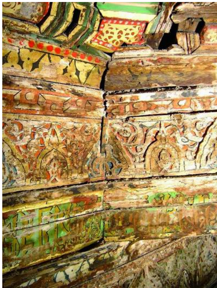
Foto 52 Cuando la humedad es alta los componentes orgánicos de la policromía constituyen un campo de cultivo ideal para los microorganismos, produciéndose una desintegración biológica.
