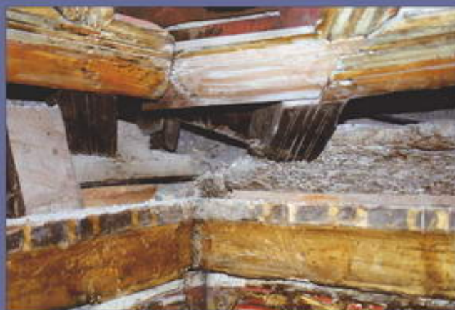
▲ Foto 4. Unión entre estribos 1 y 4.
