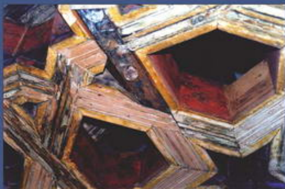
▲ Foto 27. Detalle de pletina metálica oclada en un reboje realizado al nudillo.
