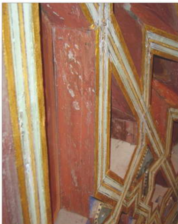
▲ Foto 57. Antes y después de la intervención.
