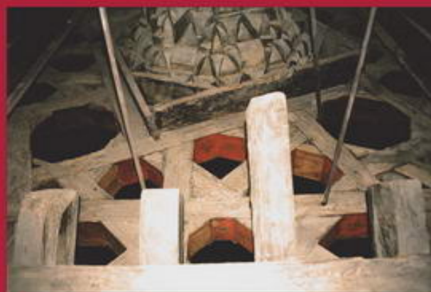
▲ Foto 25 y 26. Pletinas metálicas en nudillos y perforación de los mismos desde el trasdós de la armadura.
