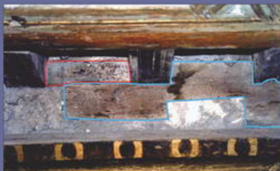
▲ Fotos 7, 8 y 9: Situación de lo que queda de la chimenea, y cortes realizados en el estribo para introducir el frente de hierro sobre el que apoyan los pares del faldón oriental).
