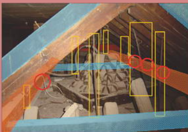
Foto 30. Elementos añadidos a la armadura. En azul, la contraarmadura. En naranja, vigas metálicas. En amarillo, gatos anclados a la contraarmadura. En rojo, gatos anclados a las vigas metálicas.
