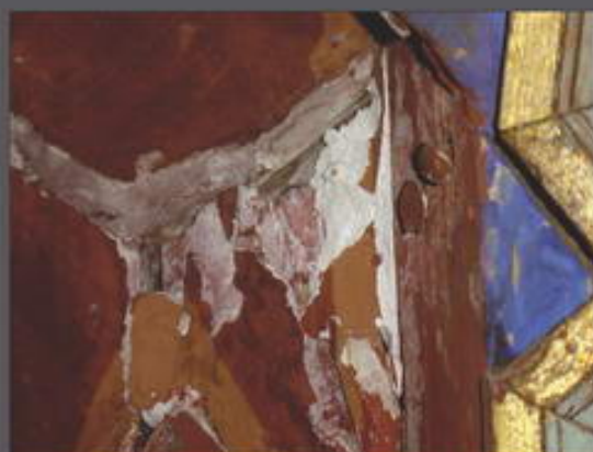
Foto 39. Superposición sobre la policromía del XVI de una una gruesa capa de preparación para tapar los desperfectos.
