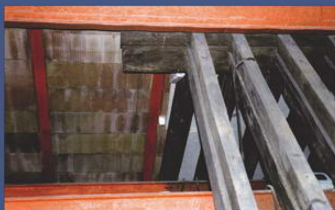
Foto 14. Contraarmadura adosada a la original.
