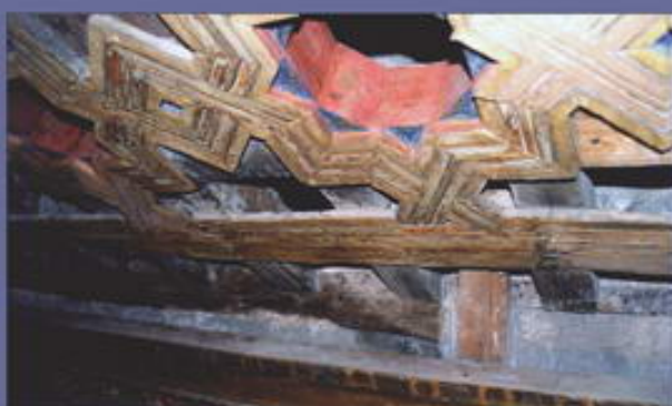
▲ Fotos 7, 8 y 9: Situación de lo que queda de la chimenea, y cortes realizados en el estribo para introducir el frente de hierro sobre el que apoyan los pares del faldón oriental).
