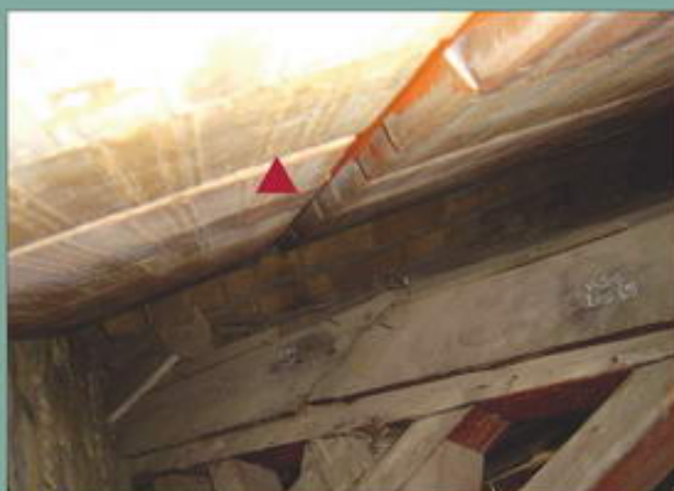
Foto 17. Espacio entre el paño sur y la cubierta del comaranchón.
