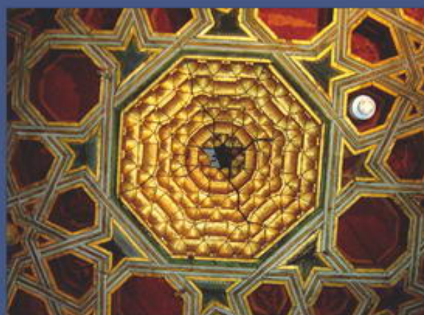
▲ Foto 28. Anclajes de hierro en peñazos soporte del cubo de mocárabes.
