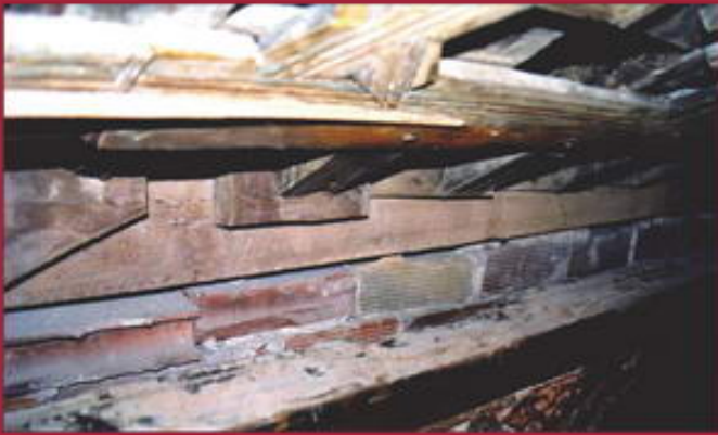
◀ Foto 10. Estribo 4 en foldón sur.
