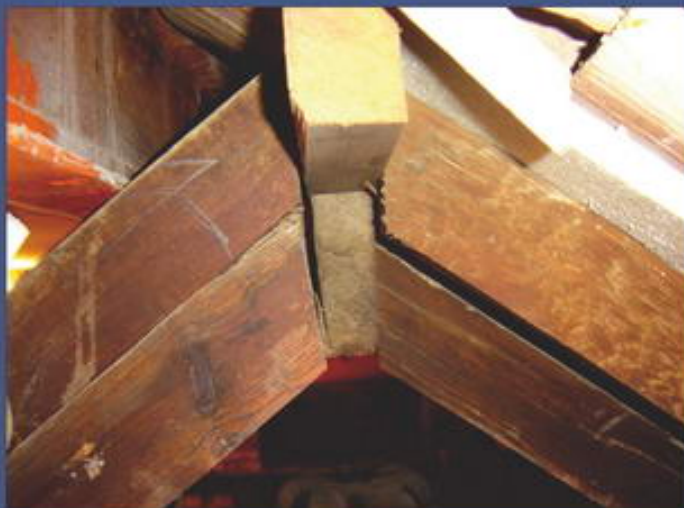
Foto 13. Contraarmadura adosada a la original.
