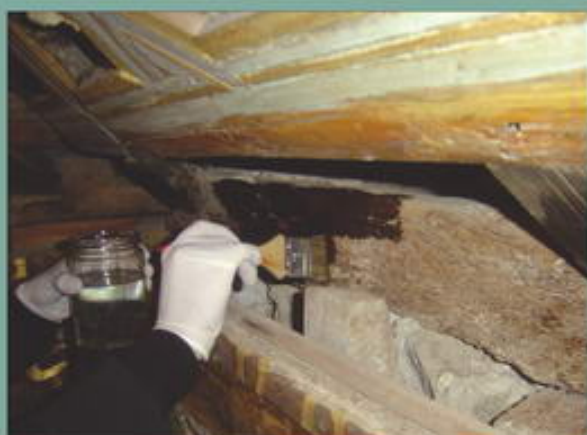
Fotos 52. Consolidación del estribo.
