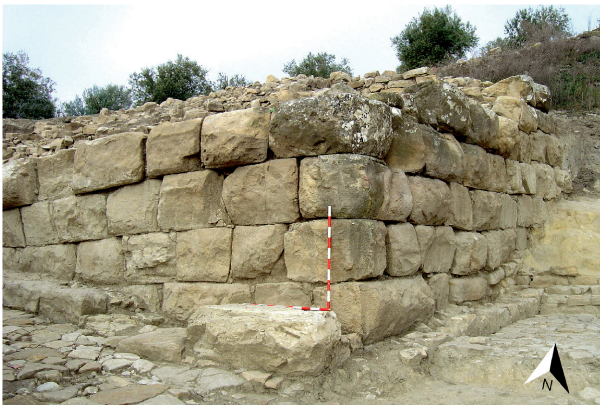
Figura 3. Detalle del zócalo de la torre norte. Obsérvese el aparejo (Imagen cedida por J.A. Morena).
