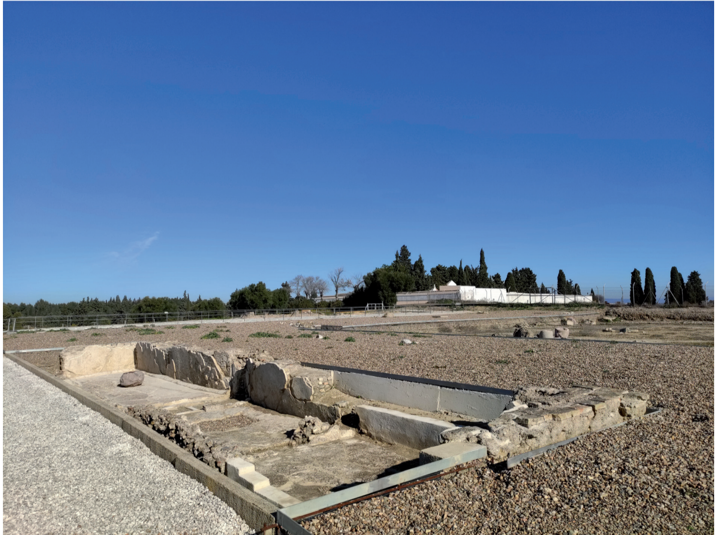
Figura 5. Estanques del Traianeum . Arriba, vista cenital antes de la restauración, con el oeste en la parte superior de la imagen. En la foto inferior, perspectiva lateral tras la restauración. Fotos S. Vargas-Vázquez.
