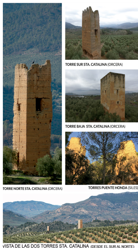
Fig. 4.- Asentamientos con presencia de torres hispano-musulmanas construidas en el siglo XII (Santiago Quesada-García)
