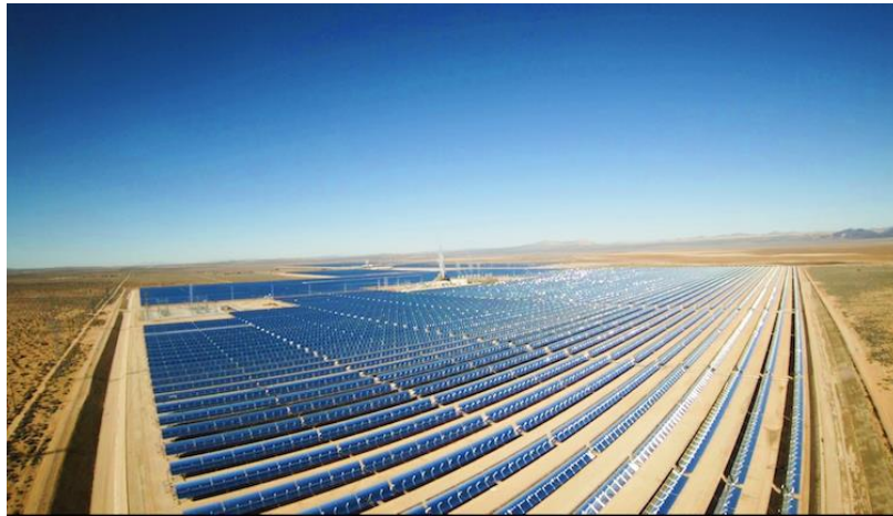
Figura 50. Campo solar de Mojave Solar. [33]
