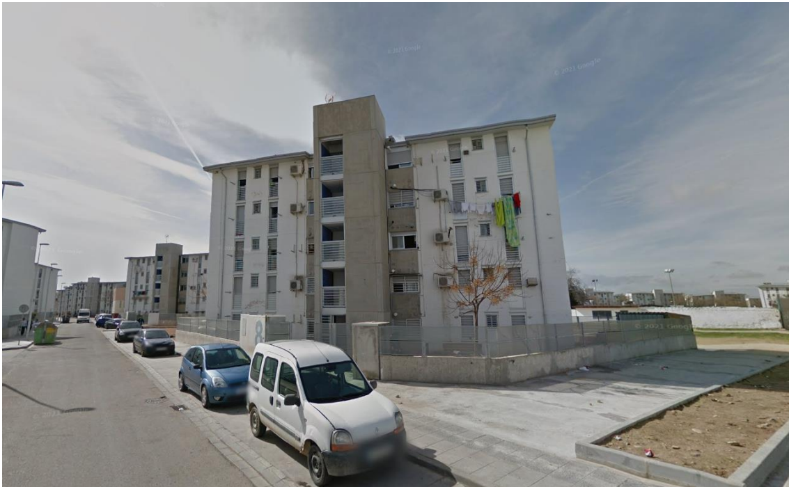
Fig. 30. Fachada principal noreste del bloque 8 en calle Torremolinos, San Martín de Porres, Córdoba, 2014. Obras de rehabilitación integral de la barriada. Fuente: Google Maps, Street View, feb 2014.
