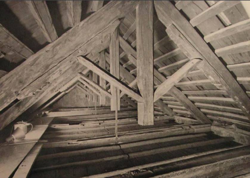
Cubierta bizantina a base de cerchas con pendolón. Santa Catalina del Monte Sinaí, s. VI
