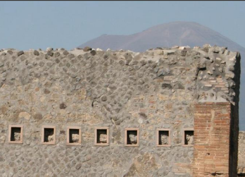
Cajeados recuadrados con ladrillo para apoyo de vigas de forjado. Pompeya
