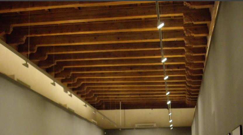
Alfarje en sala de planta baja del Espacio Santa Clara, posiblemente primera mitad del s. XVI
