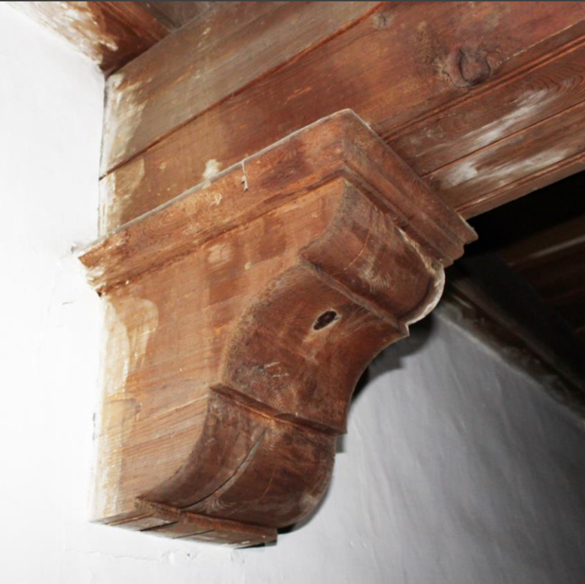
Can de apoyo de jácena de la sala 7
