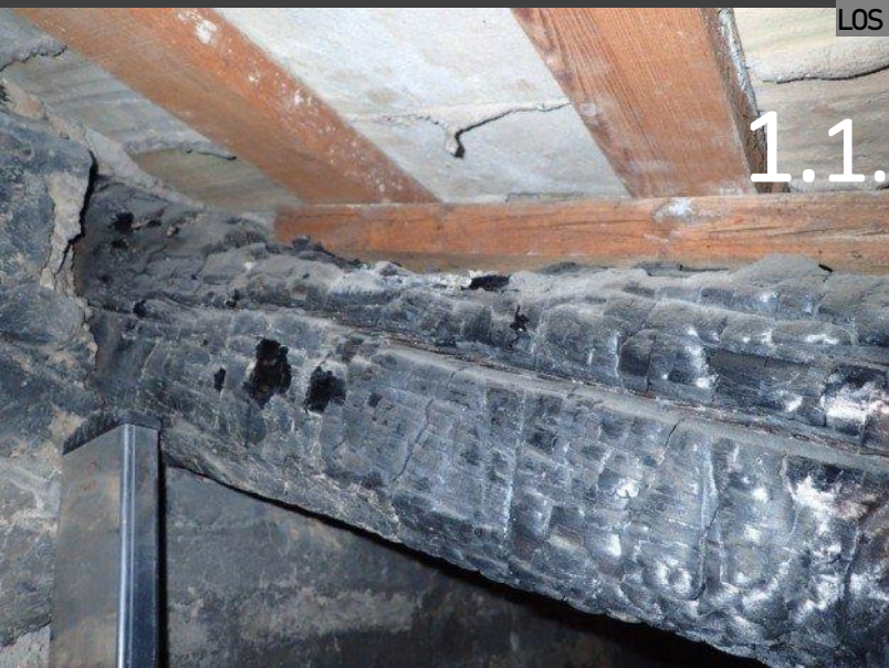
Viga de madera con superficie carbonizada tras incendio
