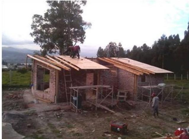
Figura 4.23. Fotografía de la colocación de la cubierta de la vivienda como caso de estudio.
