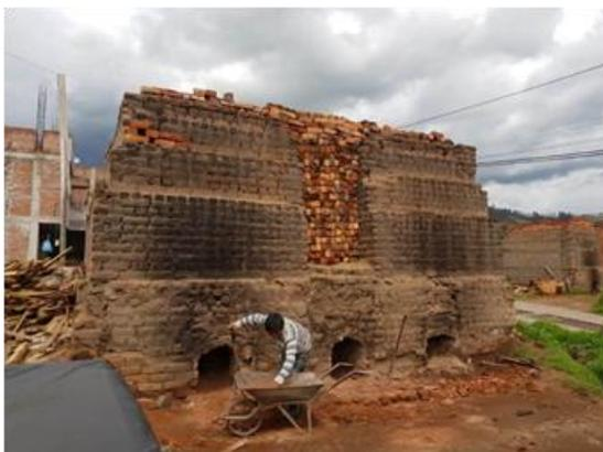
Figura 4.14. Sellado del horno.
