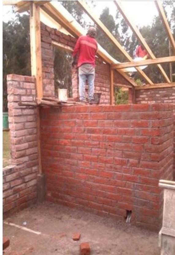
Figura 4.20. Fotografía del levantamiento de un muro con ladrillo en la vivienda de caso de estudio.
