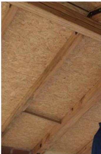
Figura 4.22. Planchas de OSB como detalle de cubierta interior.
