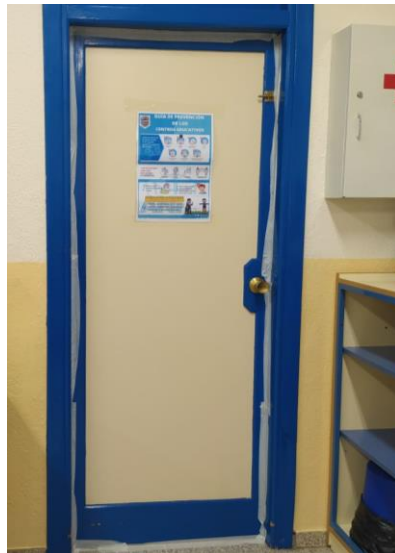
Fig. 27 Sellado de las carpinterías del aula. Fuente: Fotografía propia
