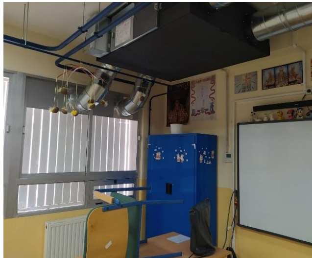
Fig. 42 Sistema de ventilación mecánica del aula de estudio del CEIP Ntra Sra del Águila (izquierda). Fuente: Fotografías propias
