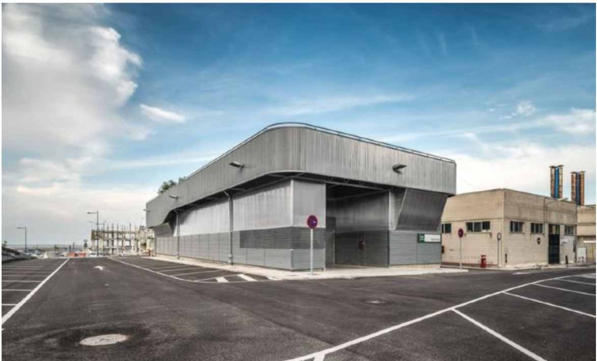
Figura 22. Central térmica y almacén colindante
