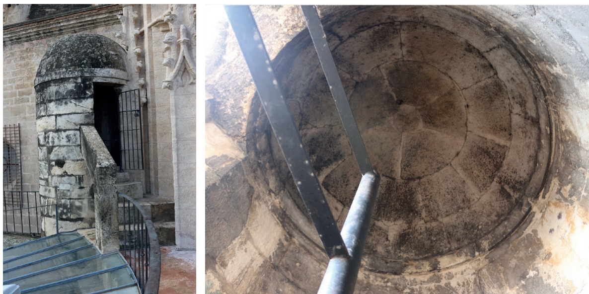
Figura 22. Cierre interior y exterior del caracol de la sala Capitular. (Foto del autor).
