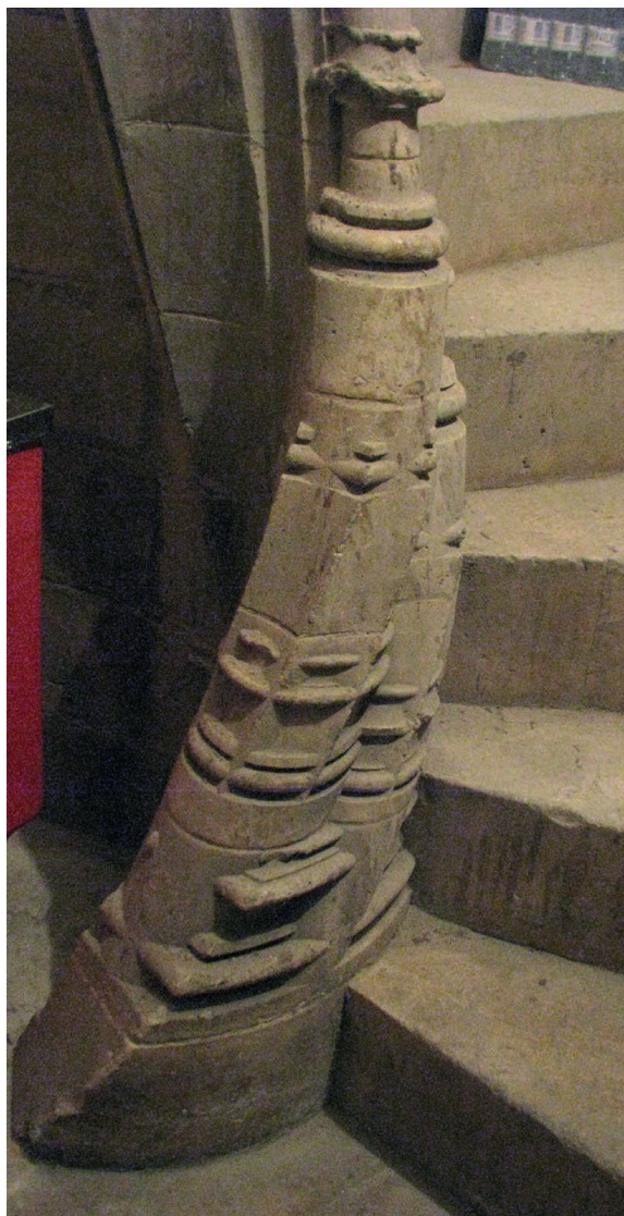
Figura 19. Detalle de basas de baquetones revirados. Caracol de la Sacristía Mayor de la catedral de Sevilla. (Foto del autor).
