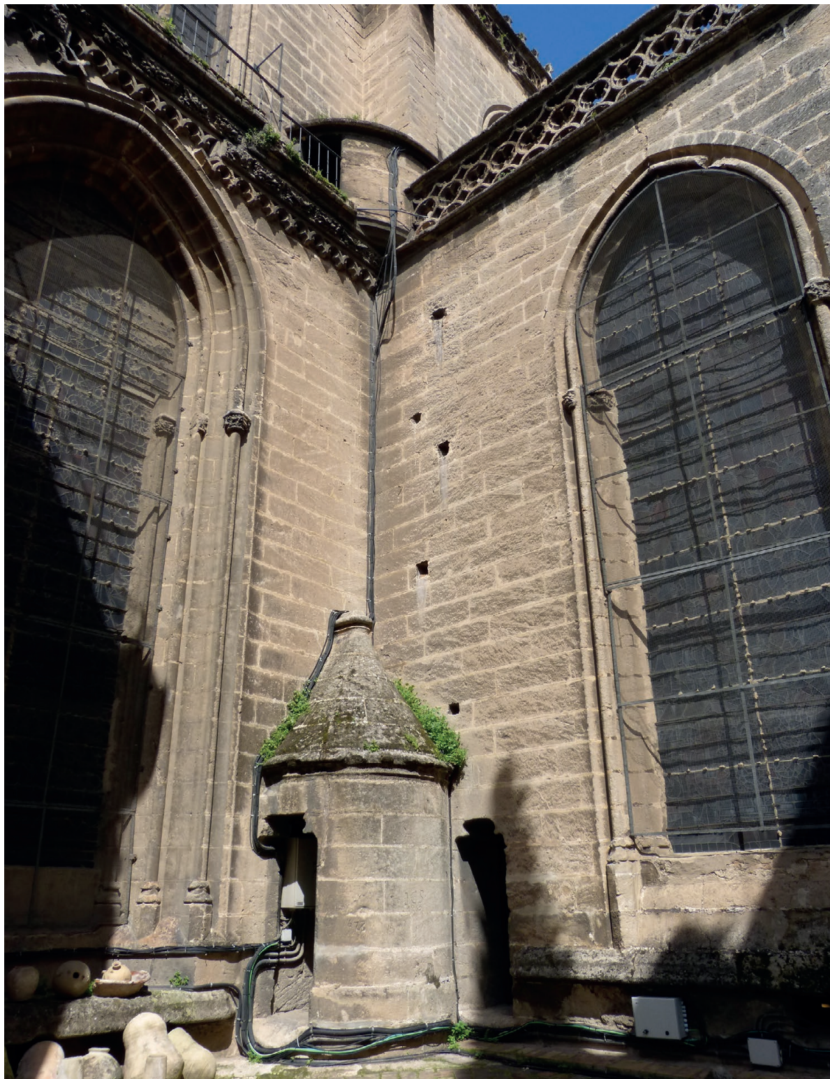
Figura 15. Escalera interrumpida sobre la capilla de los Dolores. (Foto de J.M. Guerrero Vega).
