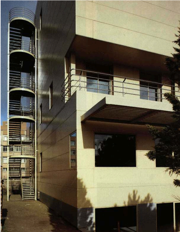
Le bâtiment de la Poste et des Communications de León (Espagne), œuvre d'Alejandro de la Sota (1981).
