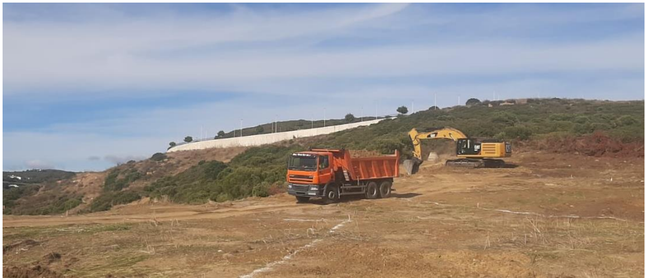
Ilustración 10 – Camión bañera acarreado tierras
