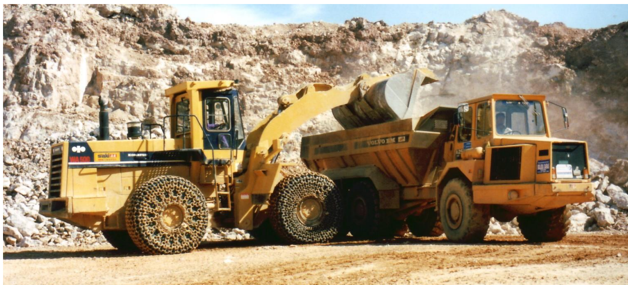
Ilustración 8 – Pala cargadora sobre ruedas durante la operación de carga de tierras
