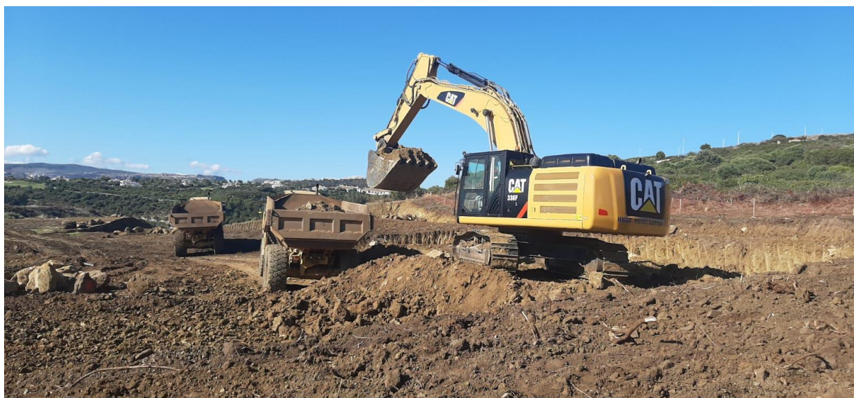
Ilustración 9 – Excavadora Caterpillar durante los trabajos
