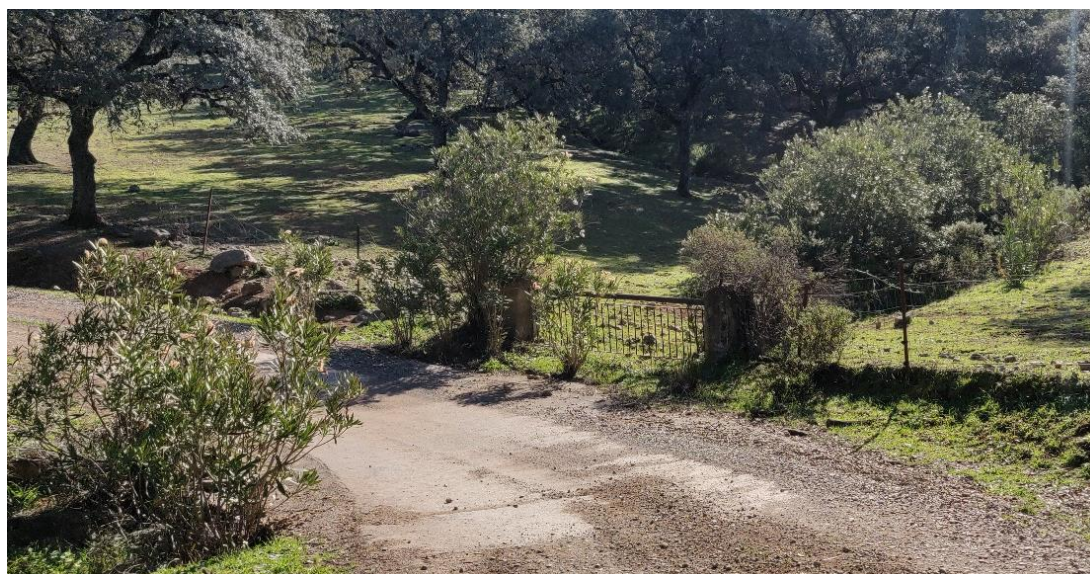
Figura 4-9. Fotografía tomada en campo del vado inundable.
