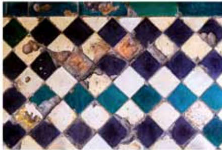
Detalle de solería de la Sala Interior de la Alcobá Real
