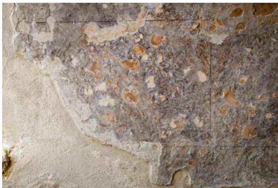
Figura 2.a. Sótanos del Palacio Mudéjar, los restos de policromías se sitúan en los paramentos interiores del vértice suroccidental de los sótanos (en la imagen corresponde a la estancia del fondo)
