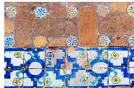
Detalle de solería de la Sala de los Pasos Perdidos
