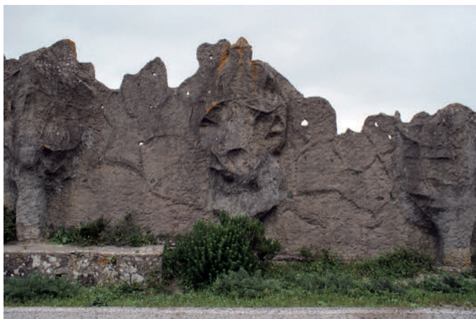
Figura 09: Detalle de la pantalla de roca artificial. Pista militar nº 7, junto a carretera de Getares, en el término municipal de Algeciras. Parque Natural del Estrecho. Detalle de uno de los pilares y la terminación irregular final. Alberto Atanasio Guisado, 2015
