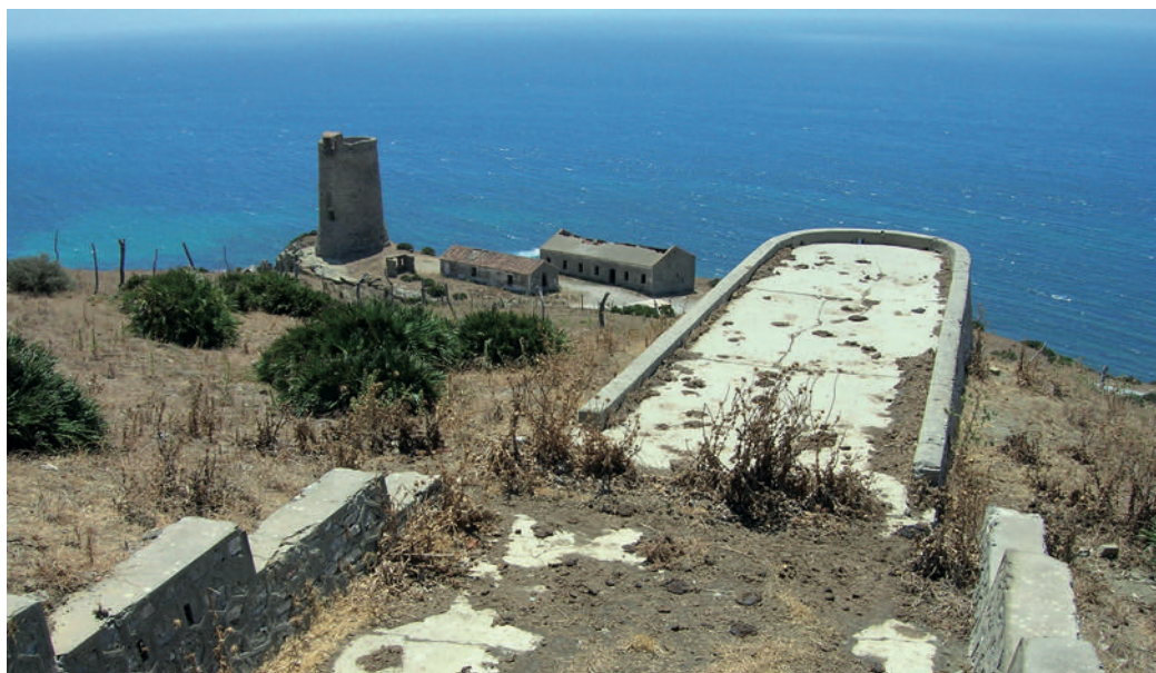
Figura 05: Torre de Guadalmesí. Junto a la desembocadura del río Guadalmesí, término municipal de Tarifa, en el Parque Natural del Estrecho. Torre almenara similar a la Torre Nueva o a la Torre Carboneras, vista desde un refugio para proyector de iluminación. Los proyectores, colocados en lugares estratégicos, perseguían iluminar el Estrecho de Gibraltar por la noche para que la artillería pudiera fijar los objetivos navales en todo momento. Federico Arévalo Rodríguez, 2005
