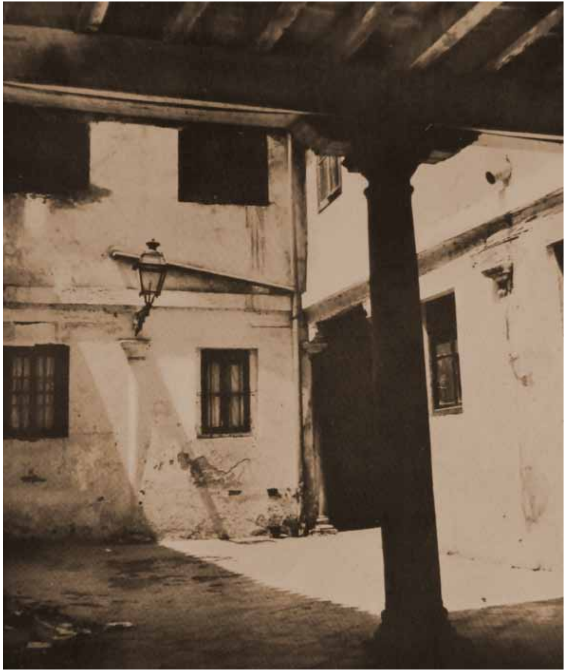
Figura 6 . Patio del Almirante (se refiere al Asistente) antes de las obras. Reales Sitios , 18, p. 67
