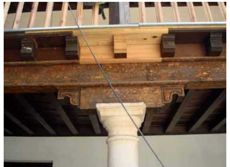
Figura 28. Detalle de la solución constructiva adoptada para evitar la compresión directa de soportes sobre viguetas (croquis superior de Víctor Mateu Quedo)
