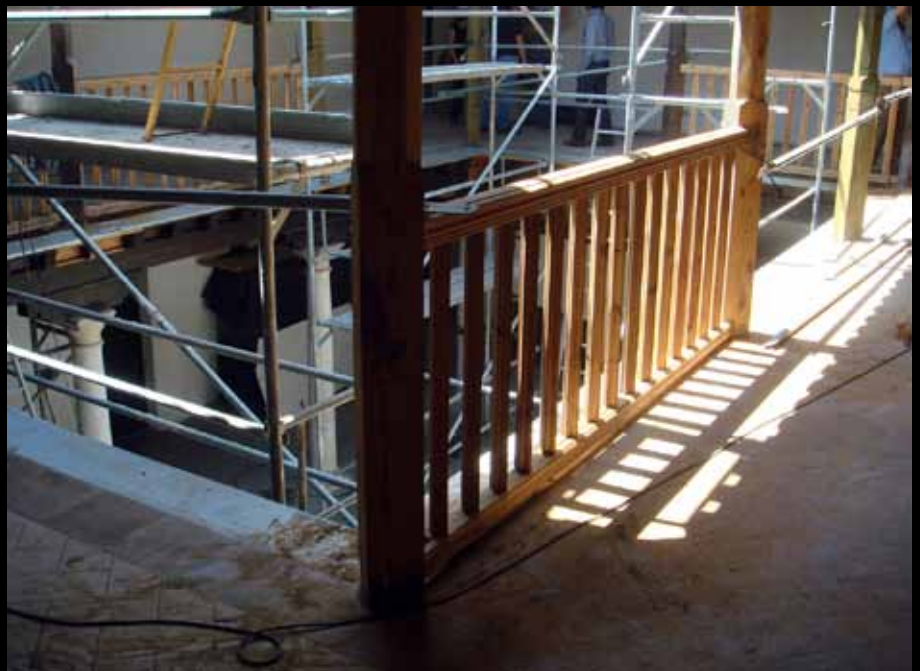
Figura 31. Diferentes estados del desarrollo de la intervención: desmontaje y montaje de cubierta, entablado y vigas de cubierta del faldón y forjado de la galería noroeste; resanado de paramentos interiores y exteriores; restauración de elementos de madera
