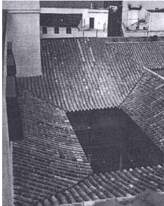
Figura 9 (izquierda). Construcción de los nuevos entramados del patio del Asistente. Reales Sitios, 18, p. 75
