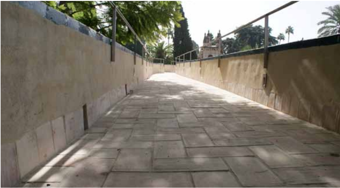
Figura 17. Estado final del paseo descubierto. Detalle de la disposición de la solería artesanal
