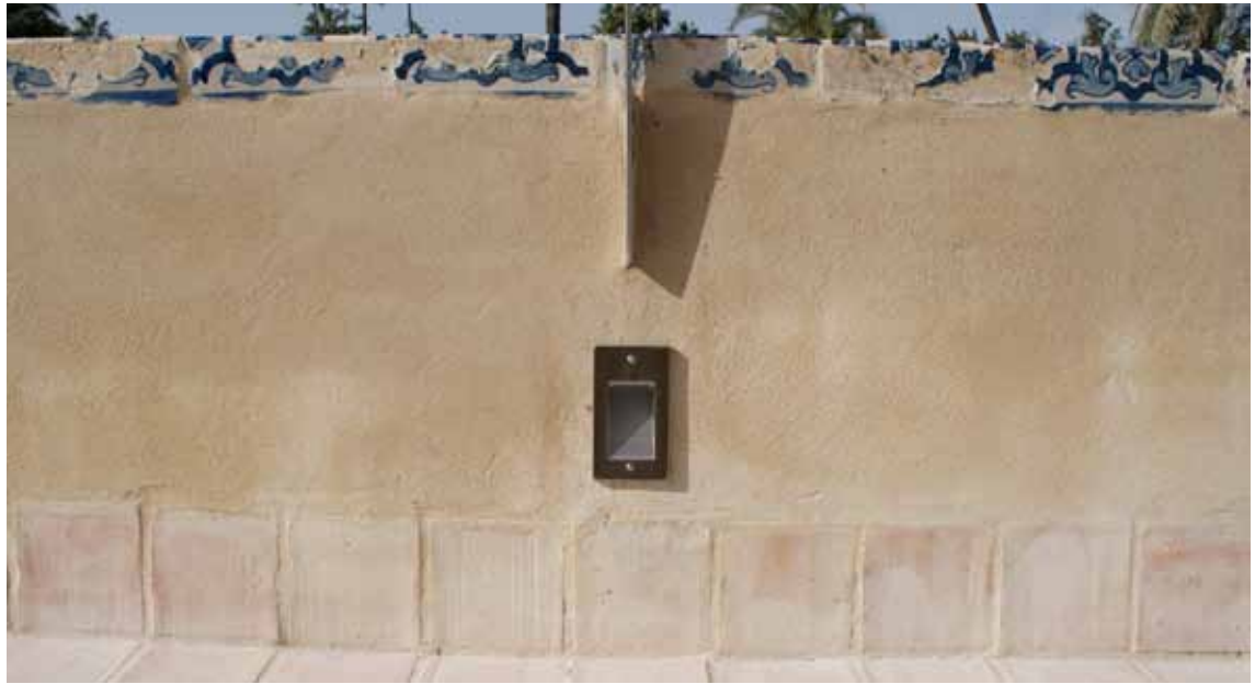
Figuras 20 a 22. Iluminación del paseo descubierto
