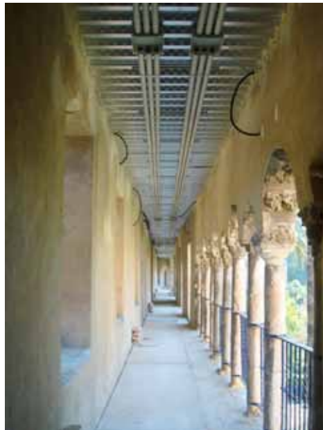
Figura 16a. Diferentes imágenes de los trabajos de adecuación y disposición de las instalaciones en el falso techo
