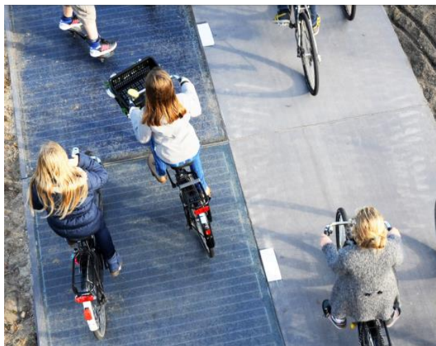
Ilustración 1 Carril compuesto por paneles solares realizado por la empresa SOLAROAD. Fuente: https://www.solaroad.nl/
