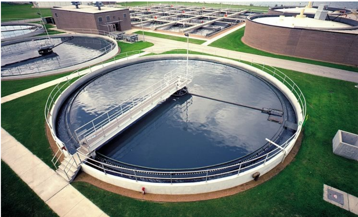
Ilustración 8 Clarificador primario [11]
