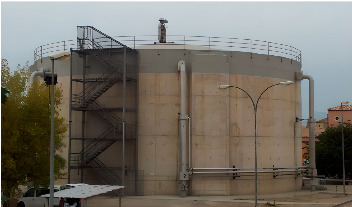
Ilustración 10 Digestor EDAR La Hoya (Lorca, Murcia) [14]
