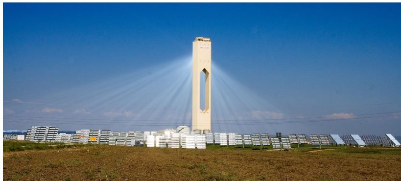
Figura 1.9 Central Termosolar PS10 de Abengoa en Sanlúcar la Mayor, primera Central de Heliostatos en el mundo..
