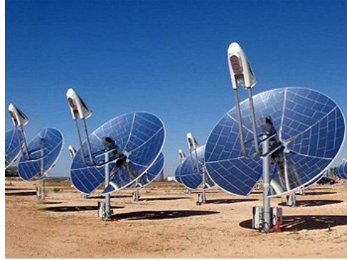
Figura 1.11 Central Termosolar con discos parabólicos en Villarobledo, primera en España de este tipo..
