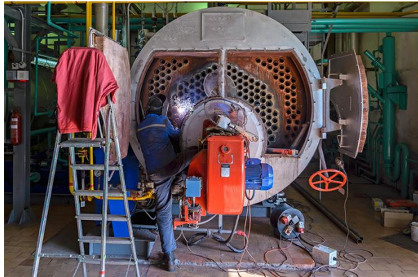
Figura 26 Operario llevando a cabo labores de mantenimiento caldera [31]
