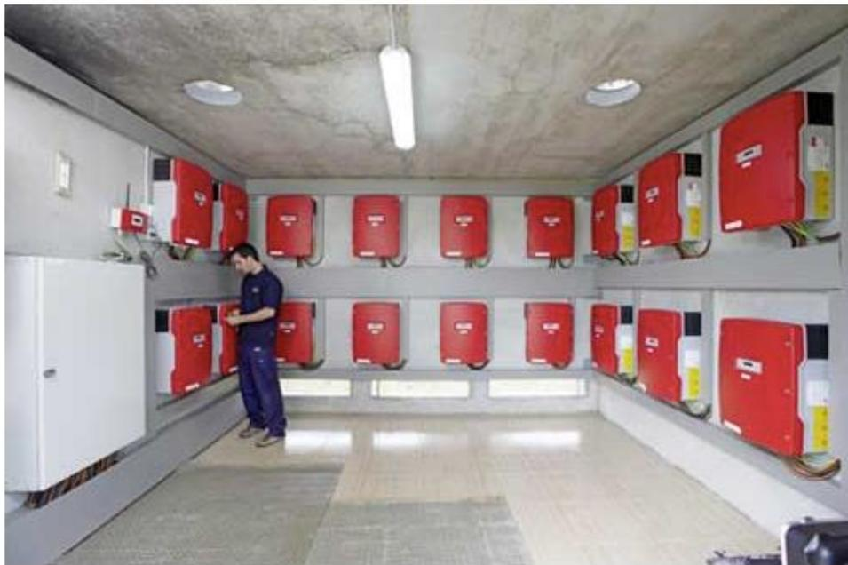
Figura 26. Inversores String en una instalación fotovoltaica [24]
