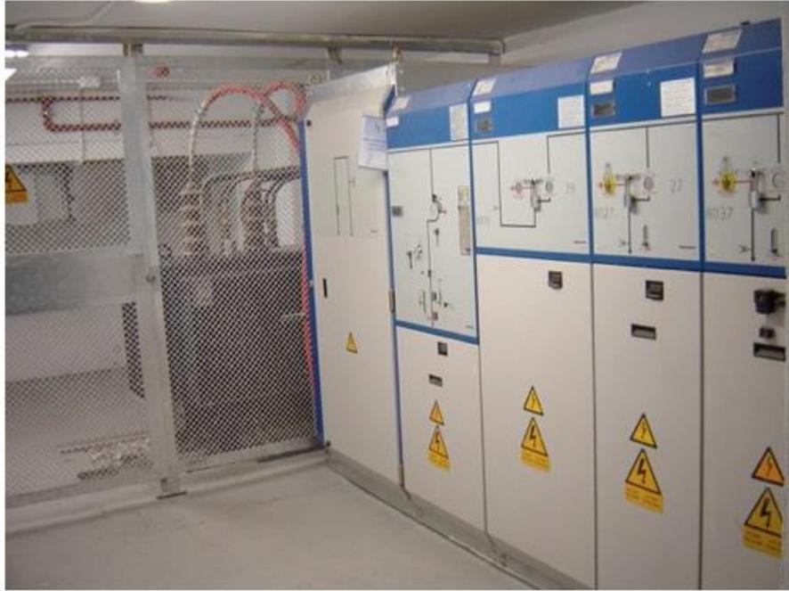
Figura 27. Subestación transformadora [13]
