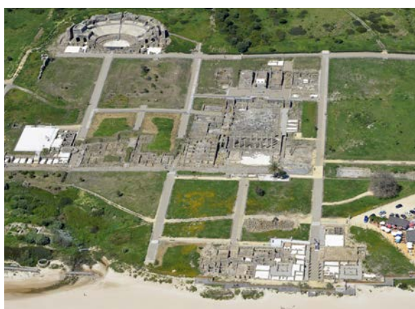
Figura 17. Imagen general de la intervención donde se puede apreciar la estructura urbana de la ciudad romana en el que los trazados de cardos y decumanus se han dimensionado de acuerdo a los datos aportados por las investigaciones arqueológicas. 2013. Fuente: TRAGSA.
