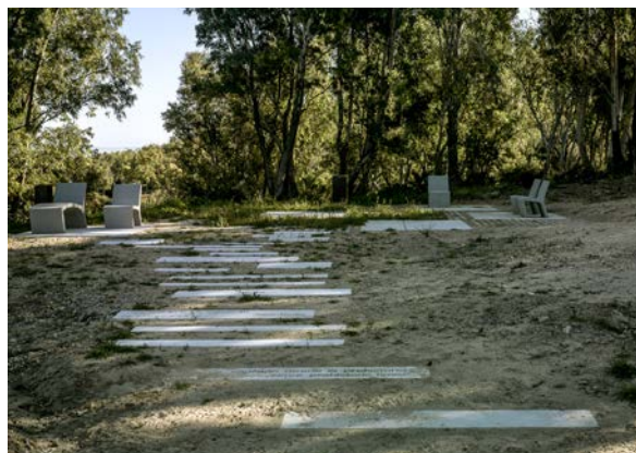
Figuras 31, 32 y 33. Piezas de hormigón prefabricado que conforman puntos de parada y áreas de estancia grabadas durante el proceso de fabricación. Fotografías: Jesús Granada.
