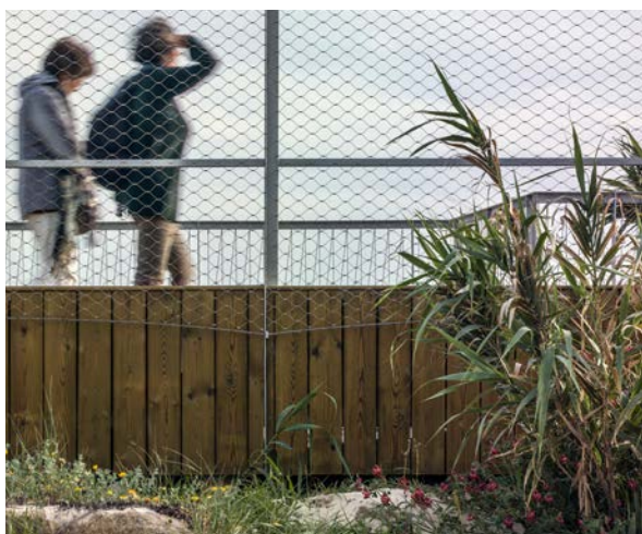
Figura 13. Detalle del cerramiento de la pasarela del borde costero desde el interior del conjunto. Fotografía: Jesús Granada.
