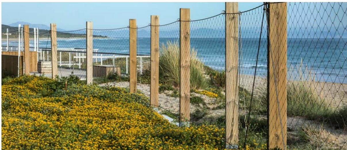
Figura 12. Encuentro entre cerramientos de malla en la pasarela. Fotografía: Jesús Granada.
