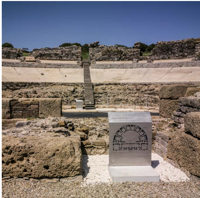
Figura 26. Señalización nominal y planimetría del teatro serigrafiada mediante hueco grabado sobre plancha de acero inoxidable anclada a base de hormigón prefabricada. Fotografía: Jesús Granada.
