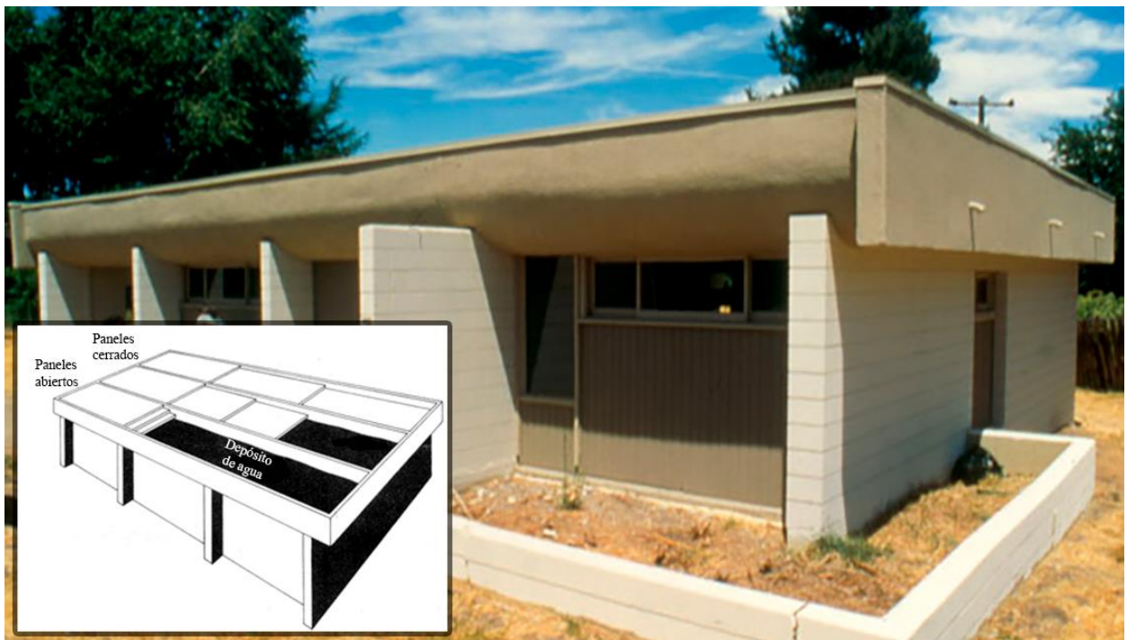
Figura 1.12 Atascadero House de Harold Hay. Vivienda experimental donde se usa la cubierta de agua
