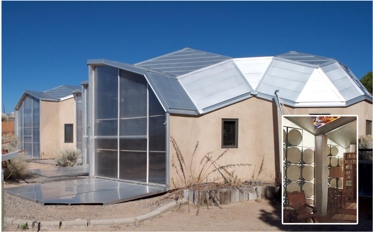
Figura 1.11 Baer House en Corrales, Nuevo México. Uso de barriles de 200 L como muros de agua
