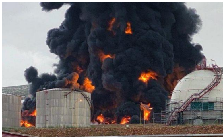
Figura 6- Incendio de los tanques de la Refinería de Repsol en Puertollano
