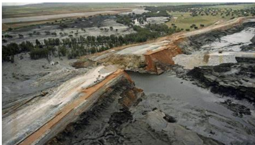
Figura 5- Rotura del dique de contención
