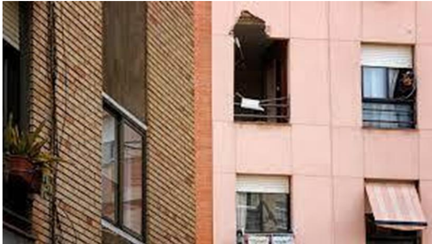
Figura 9- Vivienda afectada por el accidente
