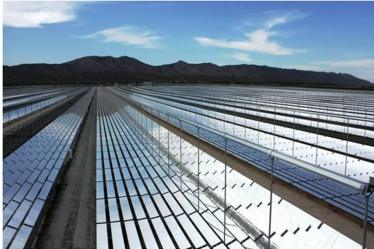
Figura 1-8. Central termosolar con receptores Fresnel
