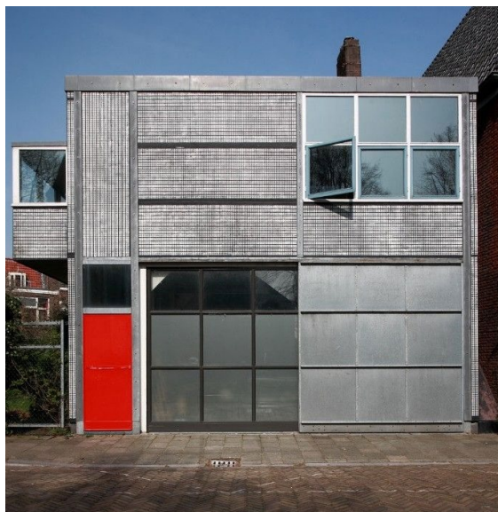
Figura 53: Fachada principal de acceso.
