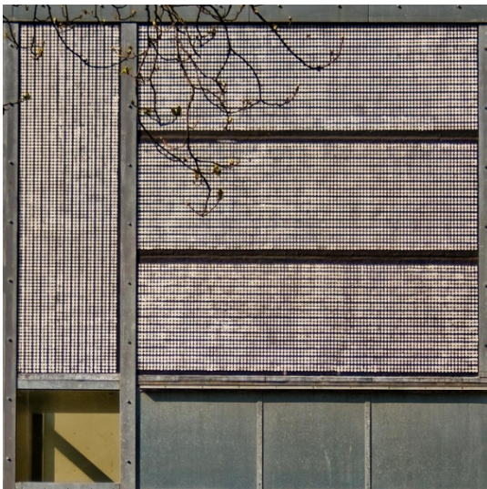
Figura 57: Vista de lejos de la aplicación del esmalte en los paneles de fachada.
