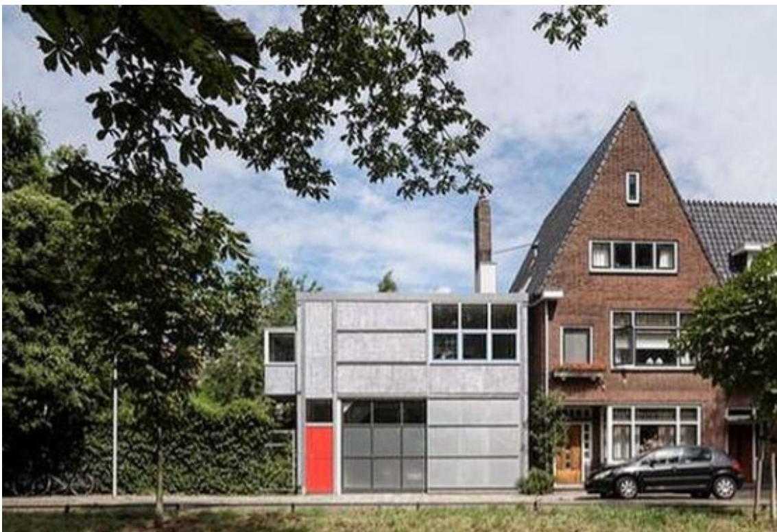
Figura 51: Exterior actual de la vivienda de H. Vuurst de Vries y ampliación para garaje y vivienda del chófer.
