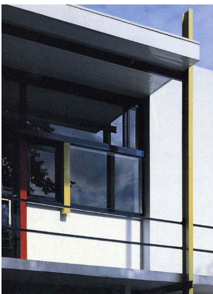
Figura 22: Detalle de la fachada sureste.
