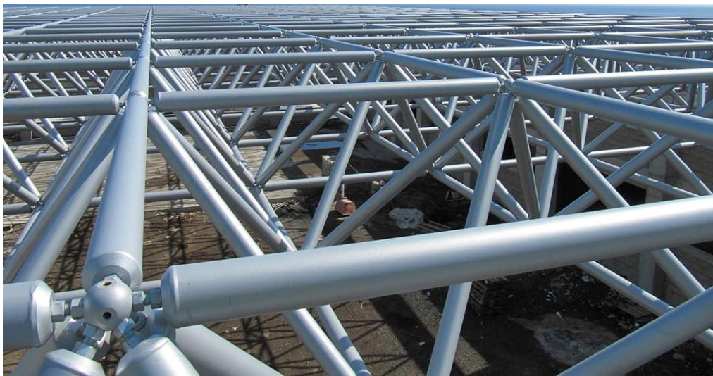
Ilustración 52. Estructura reticulada de elementos nudo – barra.
