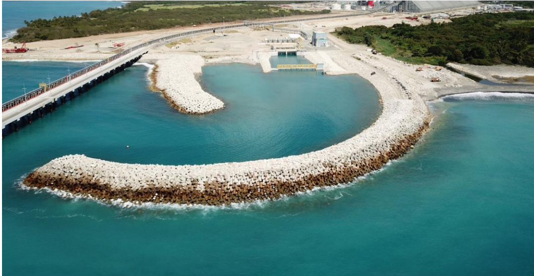
Ilustración 2-12 – Rompeolas ejecutados en el proyecto
