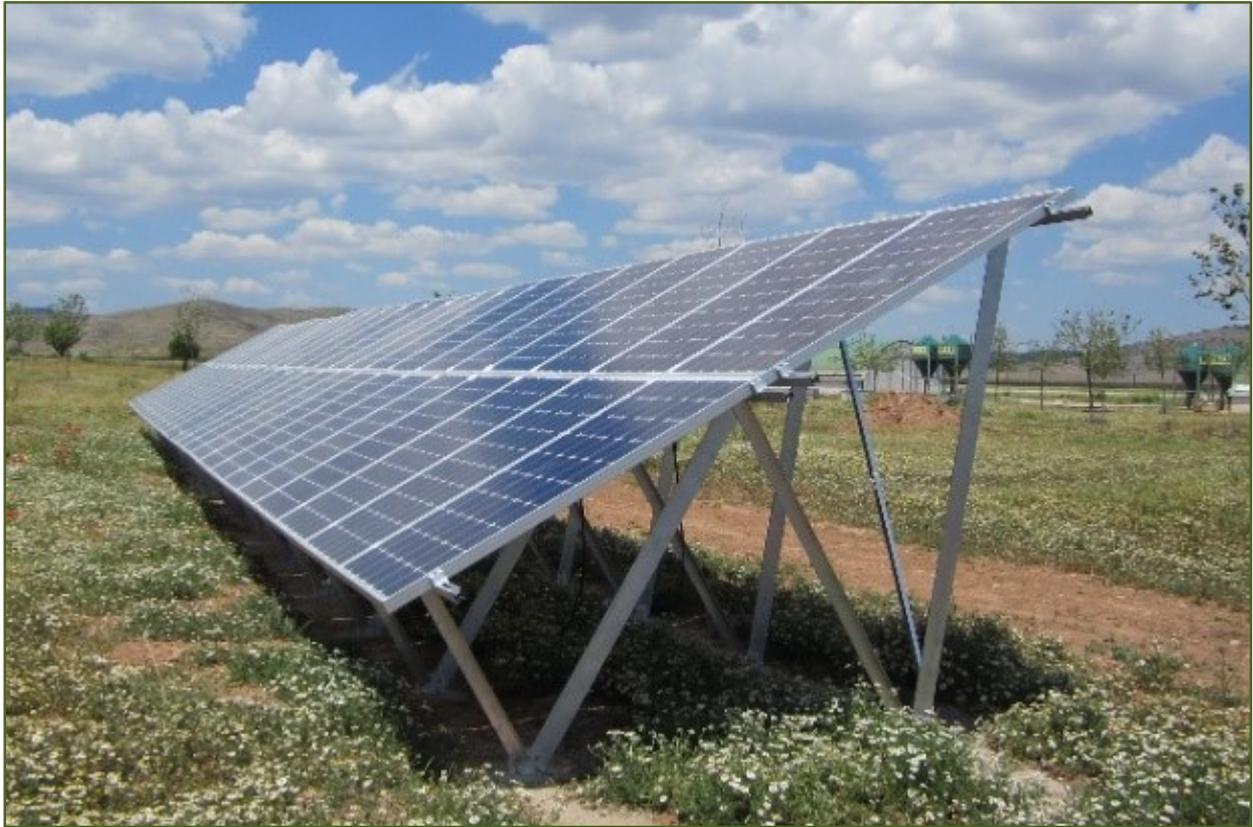
*Figura 4-11. Estructura terrestre con inclinación de  $30^\circ$ . Cortesía de Suports*
