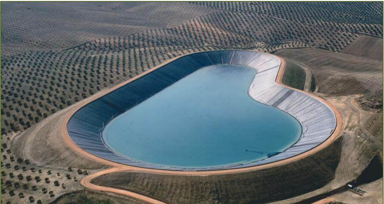
*Figura 1-4. Balsa de riego. Cortesía de Atarfil Geomembranes*
