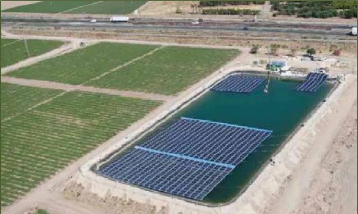
*Figura 2-2. Ejemplo de instalación FV flotante. Cortesía de Isifloating*
