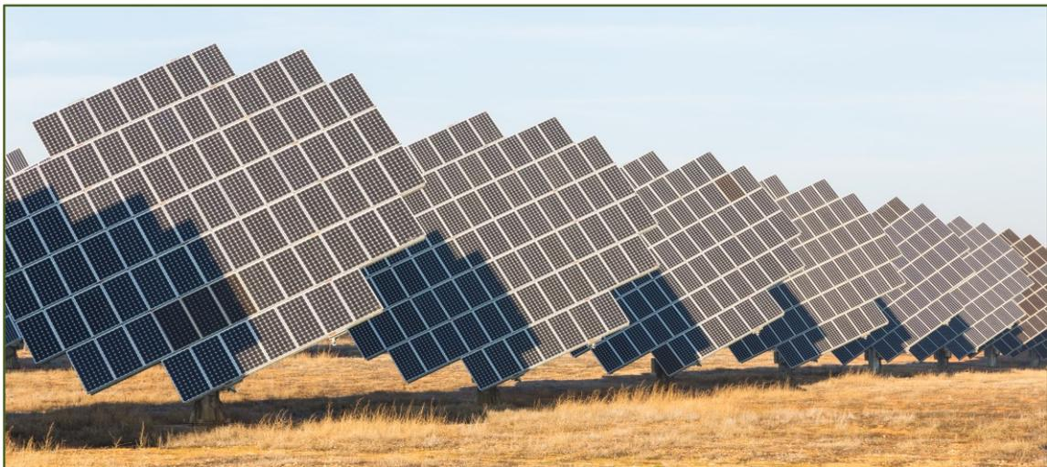
**Figura 4-17. Estructura con seguidor a dos ejes. Fuente: Wikipedia (foto de Diego Delso).**
