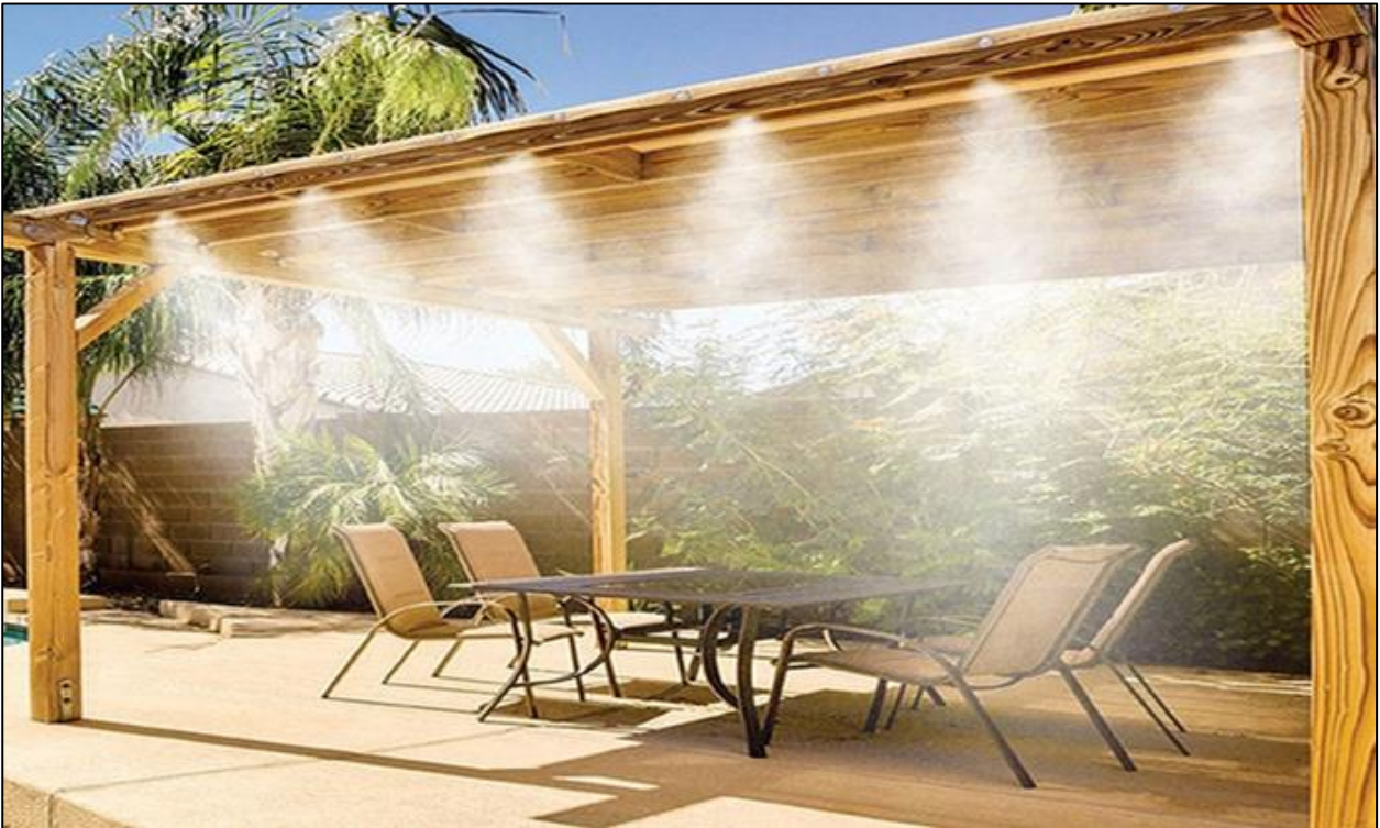
Figura 14. Ejemplo enfriamiento latente: micronizadores
