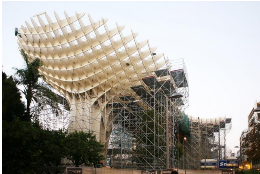
Figura 3.8. Construcción de las Setas de la Encarnación
