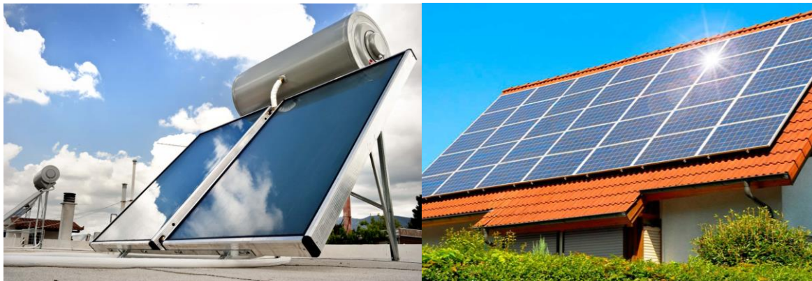
Figura 2-13: Placa termosolar (1) y placa fotovoltaica (2).
