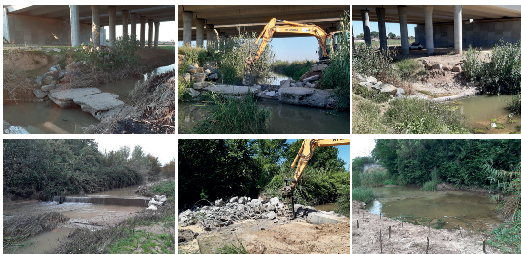
FIG. 7/ Evolución de los trabajos de recuperación de la conectividad longitudinal (arriba, demolición de azud 'SE-40'; abajo, demolición de azud 'Madre Vieja')
