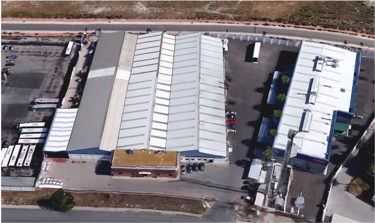
Figura 18: Vista de la cubierta de la nave.
