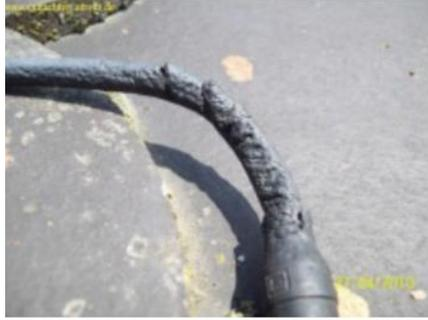
Ilustración 80. Cable en mal estado [30].
