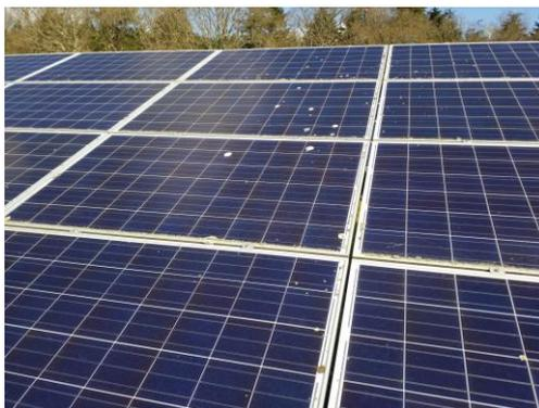
Ilustración 76. Paneles de la Planta #2 con suciedad.
