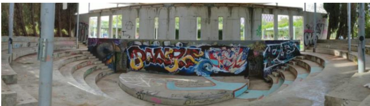
Figura 1-9. Imagen frontal interior anfiteatro antes de la reforma.
