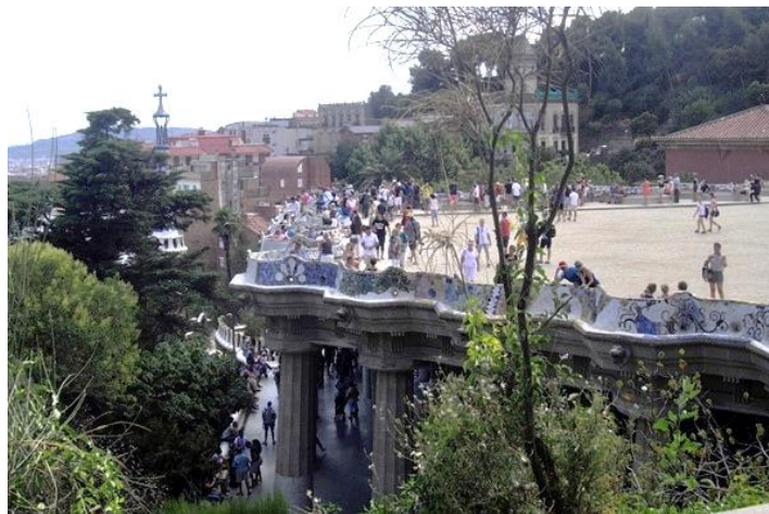
Figura 1-5. Parque Güell, Barcelona. Vistas de la plaza central y columnas de drenaje.
