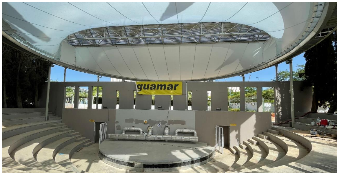
Figura 1-10. Situación del anfiteatro tras la remodelación en el mes de junio de 2022.
