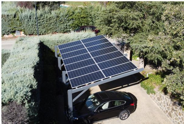
**Figura 1.2** Estación de carga de vehículos eléctricos con soporte fotovoltaico[9].
