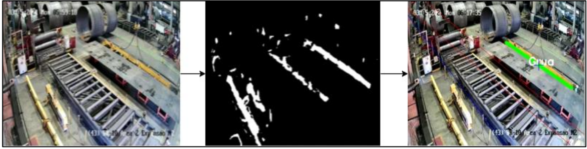
Figura 4–12. Detección de la grúa empleando Tfa. de Hough probabilística con OpenCV.
